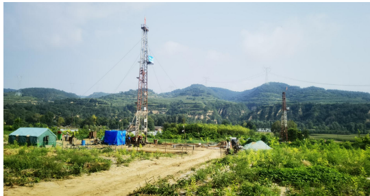
钻探期间施工照片（施工营地）
