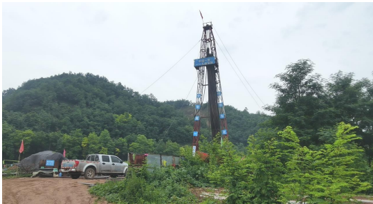
钻探期间施工照片
