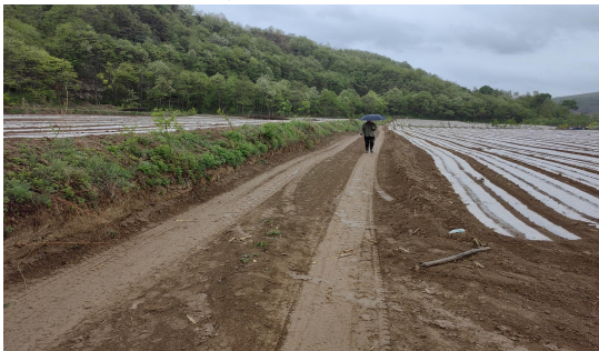
J3 临时进场道路
