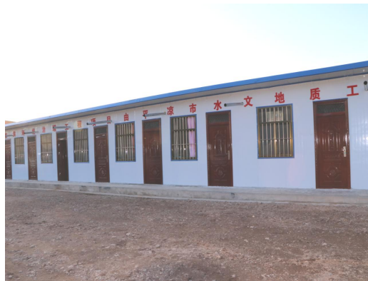
施工期间生活用房全景
