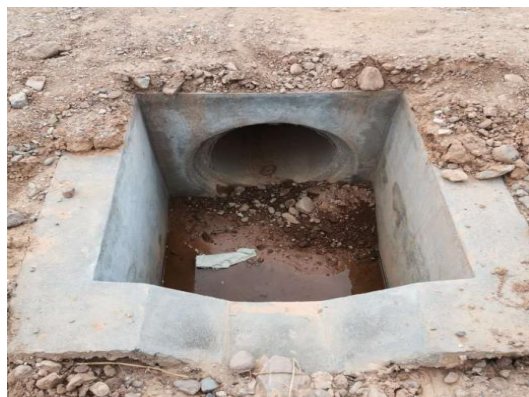
河堤堤顶涵管
