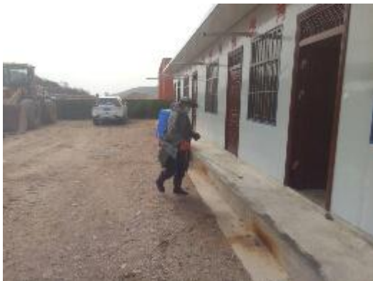
施工期间生活用房留影
