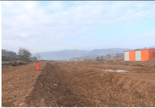
治理过程中平整的河堤与修建的工棚 (右侧黄色棚子)
