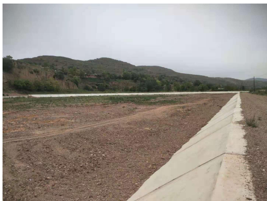
河道疏浚平整后的河堤
