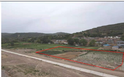
临时工程恢复情况 (照片中河岸北侧红色线条区域)
