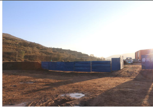
治理过程中修建的临时工程边界
