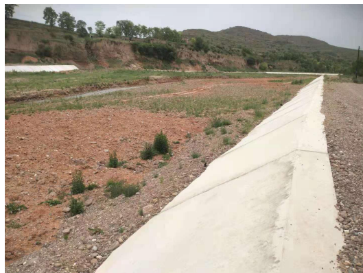
河道疏浚平整后的河堤
