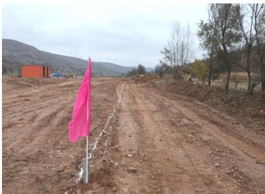
河堤施工放线
