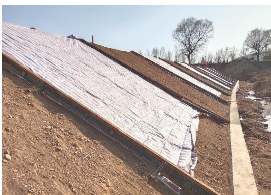
河堤护坡支模
