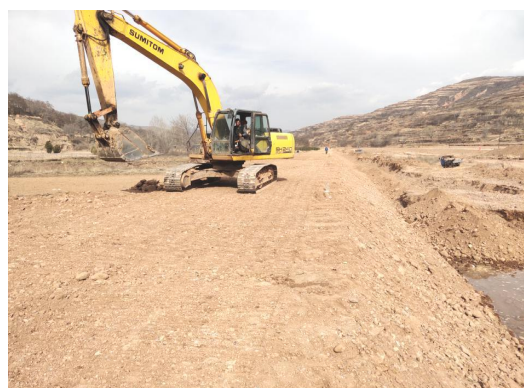
河堤堤顶平整
