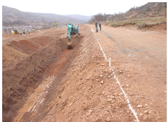
河堤基础开挖
