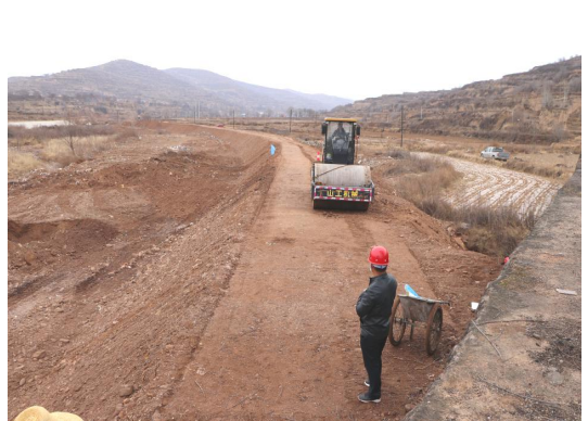
河堤堤顶碾压
