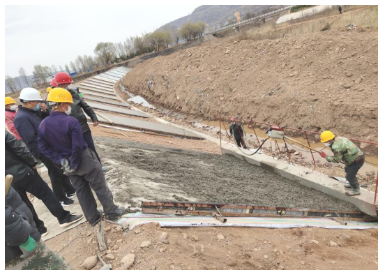
河堤护坡砼支模浇筑
