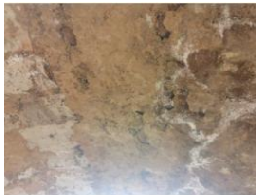
原有桥梁现状照片
