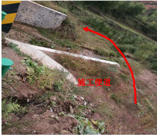
施工便道恢复现状（生态恢复）
