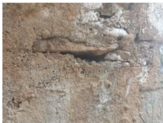
原有桥梁现状照片
