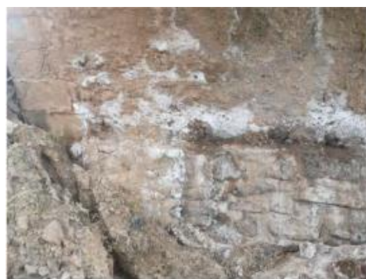
原有桥梁现状照片
