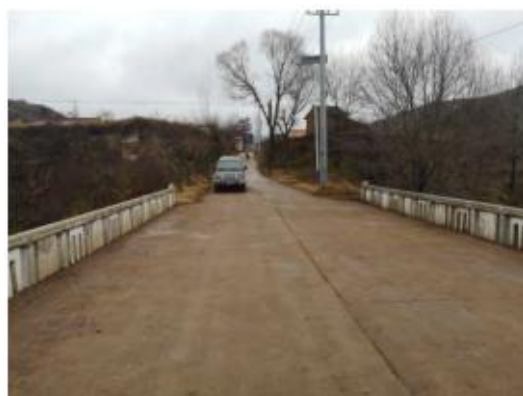
原有桥梁现状照片
