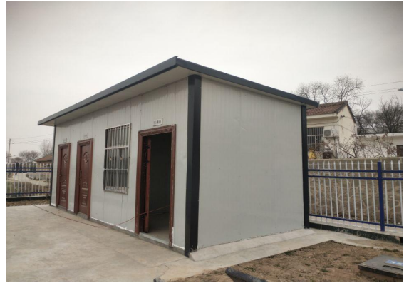
在线设备间及危废间
