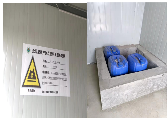
危废标识及防渗围堰区
