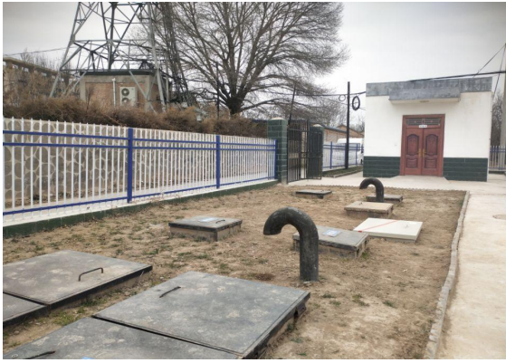
地埋式污水处理区
