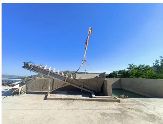
洗车平台沉淀池
