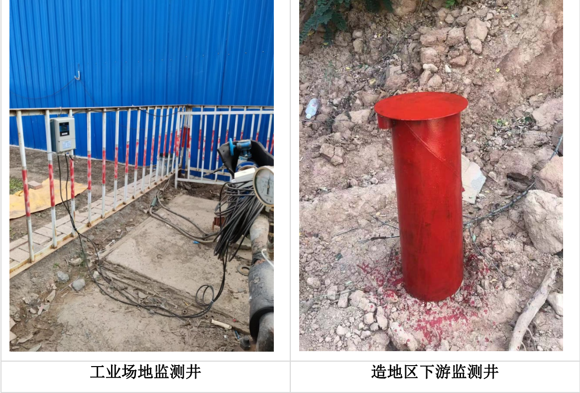
图 5.2.2-1 地下水监测井照片
